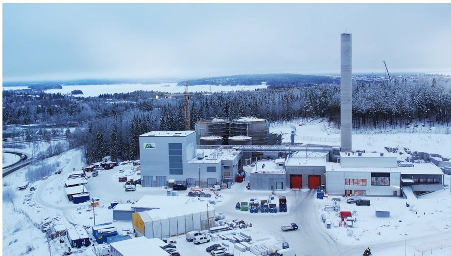
Sulkavuoressa toimistotilat (oikeanpuoleinen rakennus) otettiin käyttöön helmikuussa ja Keskuspuhdistamon toimisto muutti sinne. Kuva: Tampereen Seudun Keskuspuhdistamo
